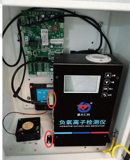
安装完成正面图
