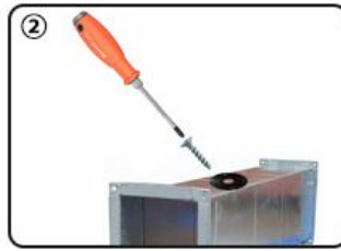
用螺丝将法兰盘固定在排风管上
