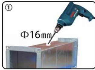
在排风管上打一个直径16mm的孔
