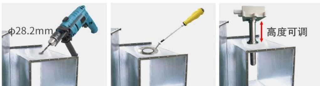
① 在排风管上打一个直径 28.2mm 的孔
