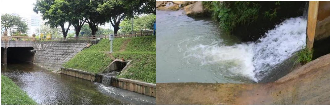
河道中管道排放口位置
