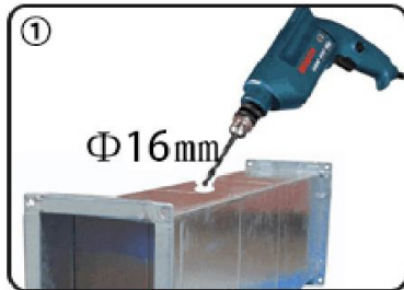
① 在排风管上打一个直径16mm的孔
