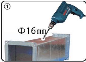
① 在排风管上打一个直径16mm的孔
