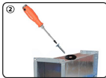
用螺丝将法兰盘固定在排风管上
