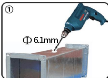
① 在排风管上打一个直径6.1mm的孔
